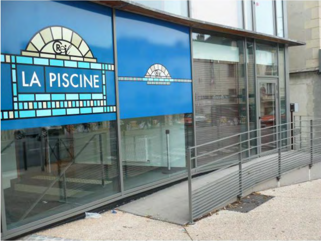
Source : Ville de Creil, 2015
